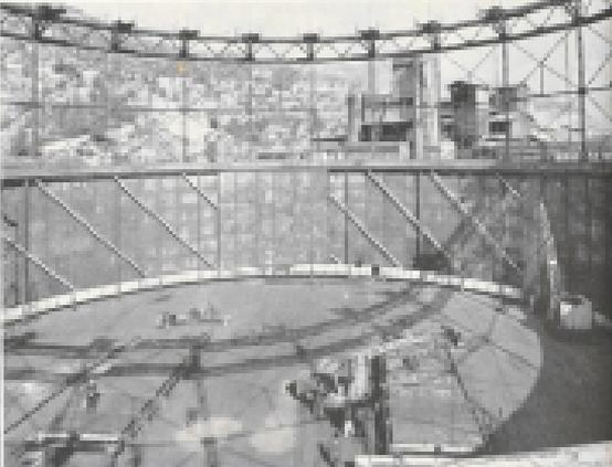
Fotografie scattate durante i lavori di montaggio del gasometro da 100.000 mc., costruito dal nostro Stabilimento CMI per l'A.M.G.A. di Genova
