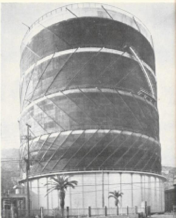
sempio è stato adottato un particolare sistema di progettazione, su speciali telai, venivano assommate le fondazioni in modo da evitare dei grandi pannelli la cui saldezza viene effettuata a terra limitando così le saldature in opera che ovviamente risultano più difettose. L'assommate dei pannelli è stato particolarmente facilitato dalla lunga forza appuratamente provvista che consentiva in quei tempi a incidere i manufatti della capanna e del telesempio.
